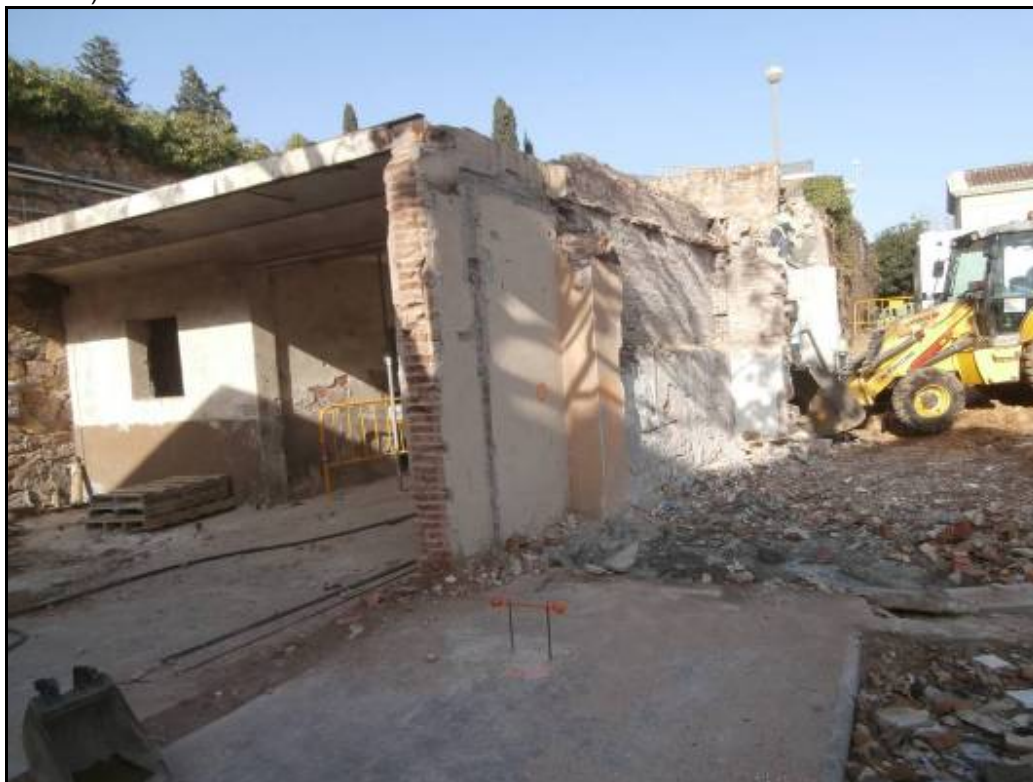
Fotografia 11: Part de l'Edifici B sense enderrocar, vist des de l'oest.
