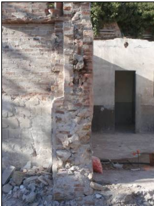
Fotografia 33: Detall dels 1'30 m de paret conservada feta amb morter de calç, i l'alçat posterior amb maons i ciment pòrtland (cos oest de l'Edifici B no enderrocat).
