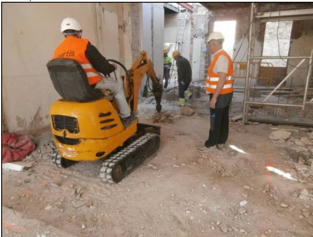
Fotografia 5: Inici del treball d'excavació de l'ascensor A, a l'Edifici A.
