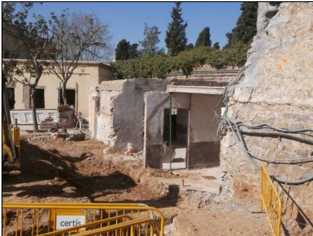
Fotografia 12: Part de l'Edifici B sense enderrocar, vist des del costat est.
