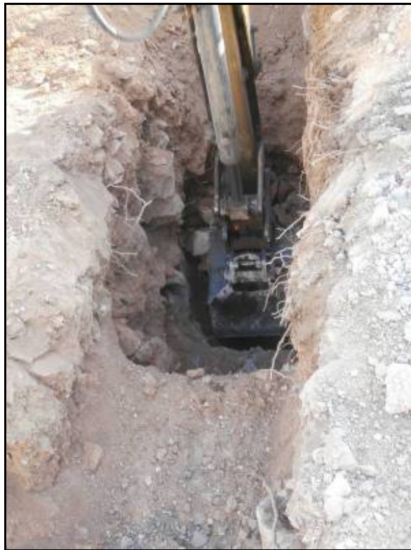
Fotografia 17: Excavació de la S-13.
