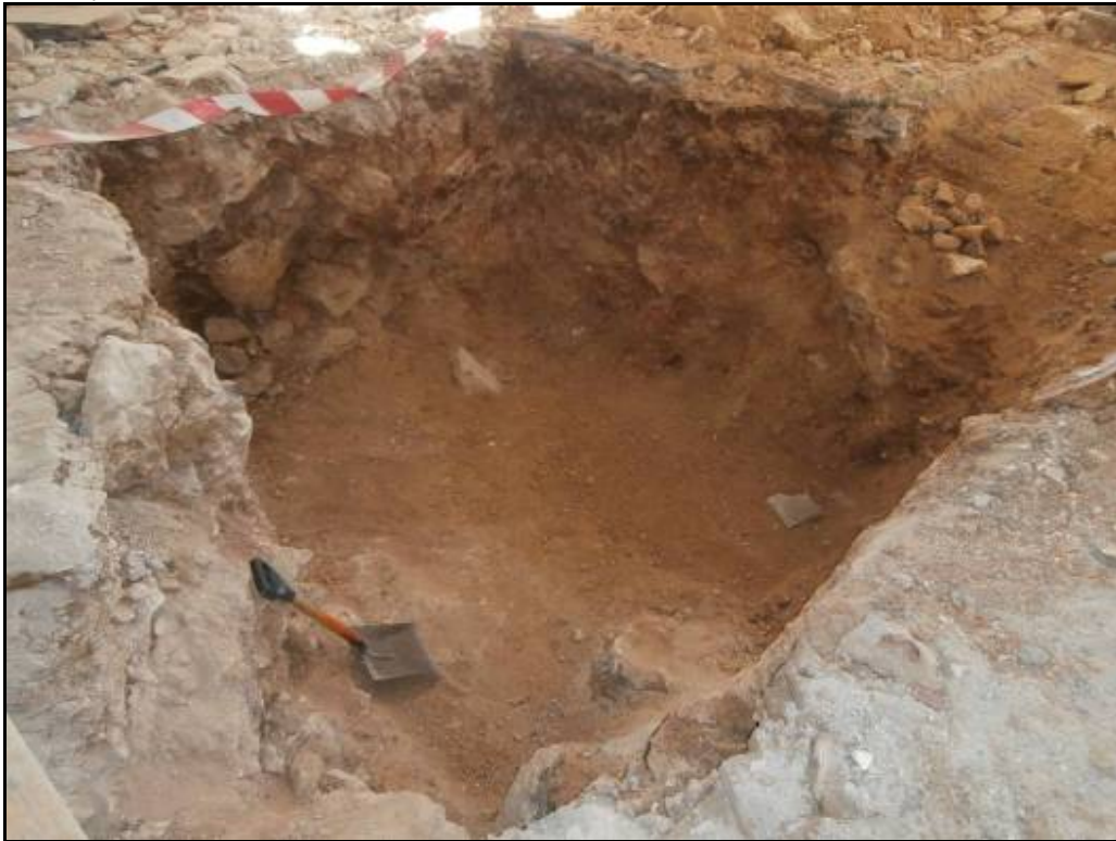
Fotografia 9: Fossat de l'ascensor A finalitzat.
