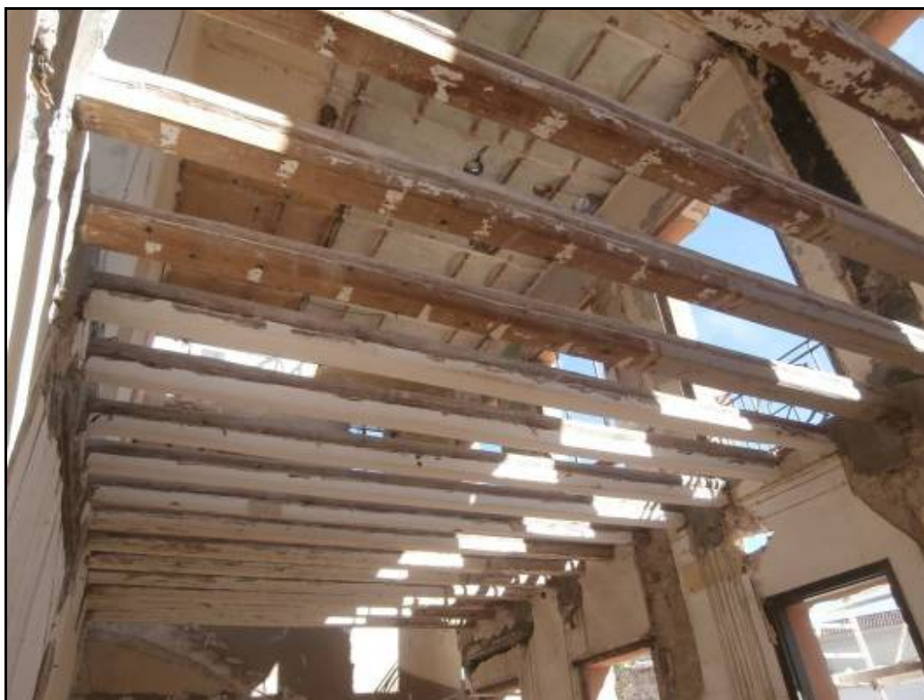
Fotografia 28: Bigues de fusta del sostre al cos principal de l'Edifici A.
