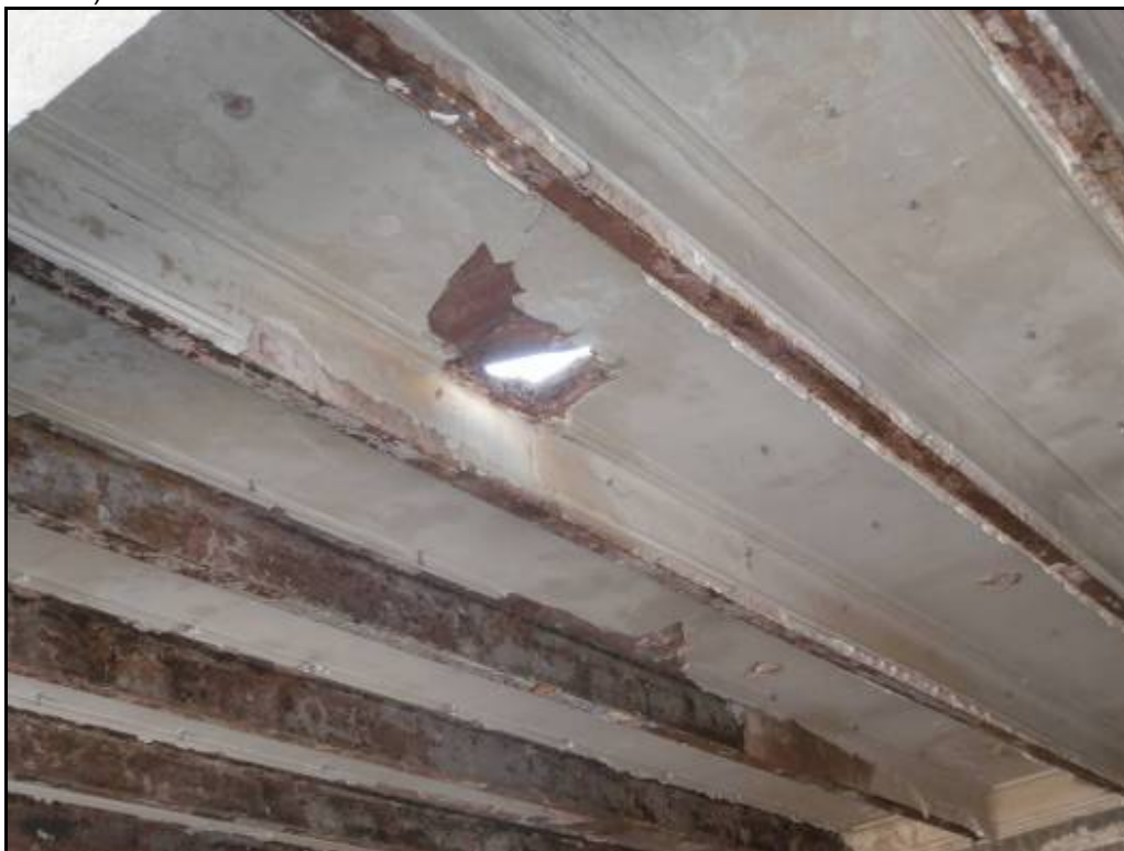
Fotografia 29: Bigues de ferro del sostre, a l'annex posterior de l'Edifici A.
