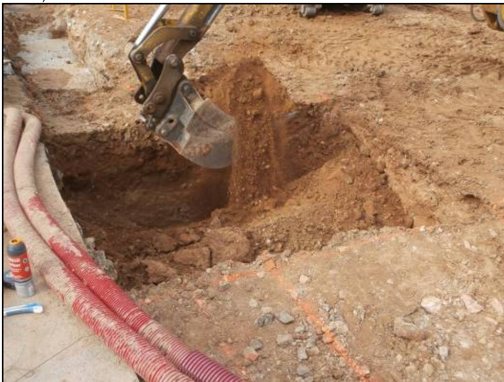
Fotografia 19: Excavació del fossar de l'ascensor B.
