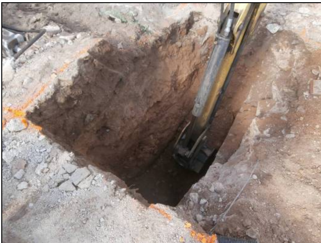
Fotografia 14: Procés d'excavació del P-1.
