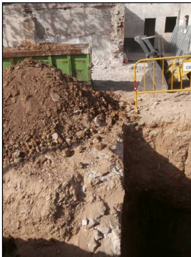
Fotografia 32: Alineació de la cimentació trobada en P-2 (en primer terme), amb l'alçat d'una paret de l'edifici B no enderrocat.
