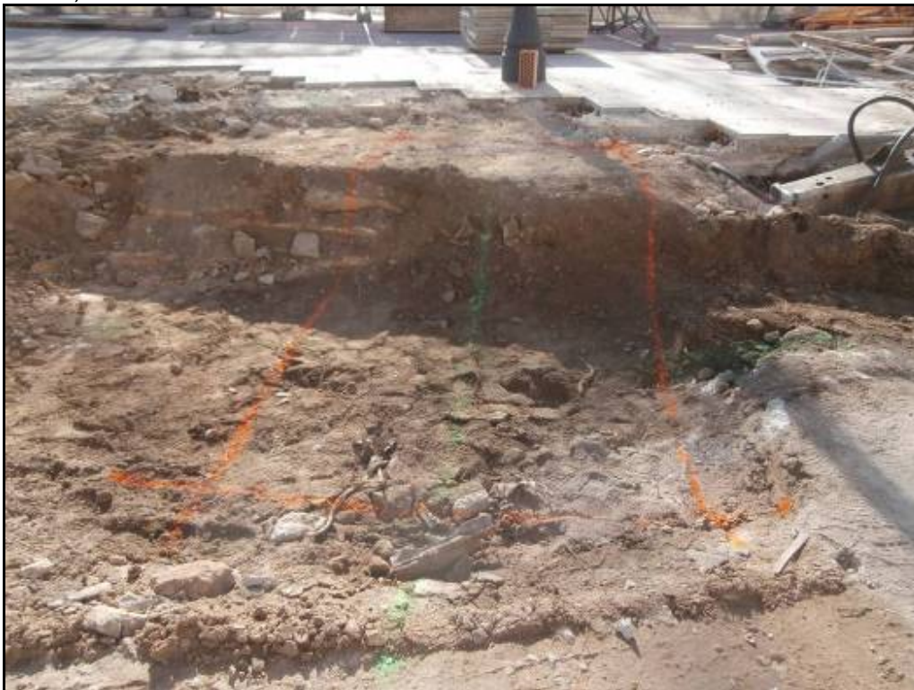
Fotografia 13: Pilar 1 (P-1) marcat al sòl abans de l'inici de la seva excavació amb màquina.
