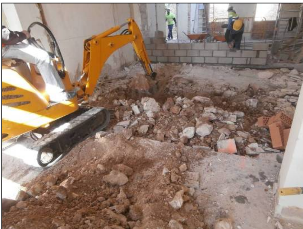
Fotografia 6: Procés d'excavació de la cala de l'ascensor A.
