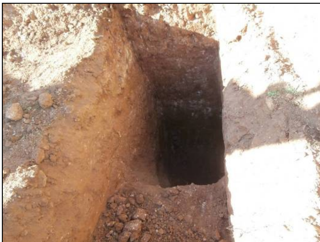
Fotografia 16: Excavació de la Sabata 2 (S-2).
