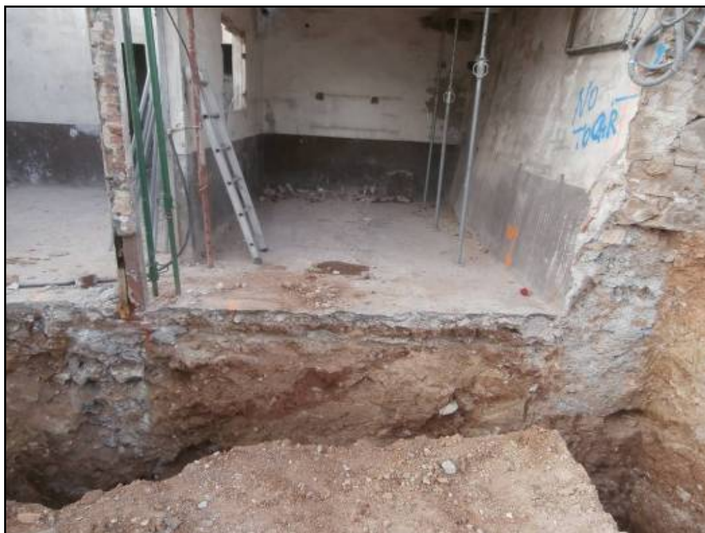
Fotografia 30: Cimentacions fetes amb ciment pòrtland, cos est de la part de l'edifici B no enderrocat, situat a la meitat nord de l'espai intervingut.
