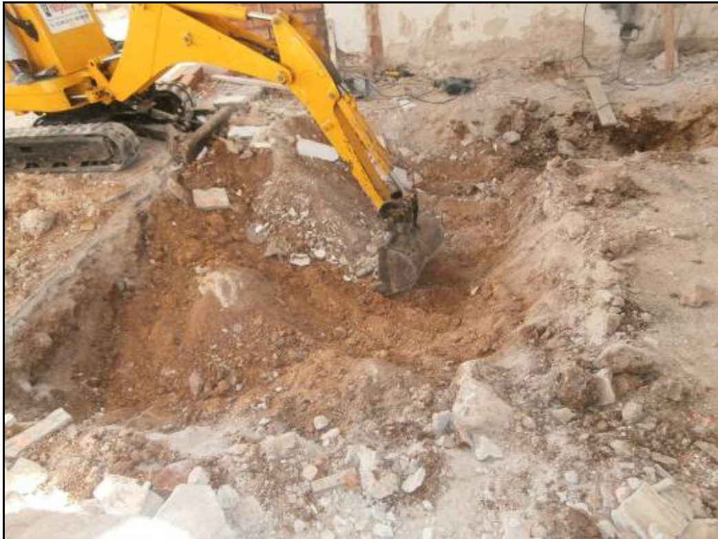
Fotografia 7: Procés d'excavació de la cala de l'ascensor A.
