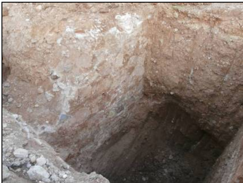
Fotografia 31: Cimentació amb morter de calç de l'Edifici B enderrocat, trobada en l'excavació de P-2, extrem sud de l'espai intervingut.
