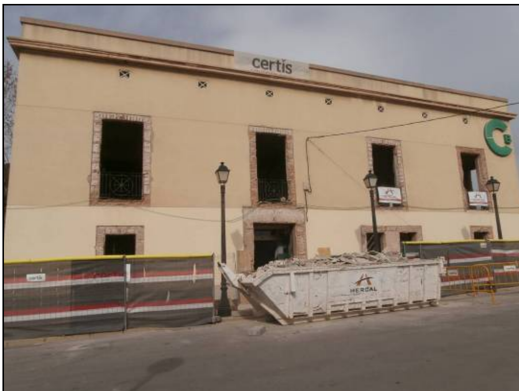
Fotografia 4: Façana principal de l'Edifici A.
