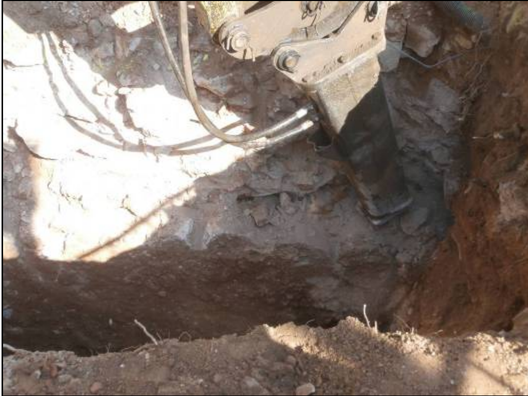
Fotografia 35: Trencament de la mateixa cimentació de la Fotografia 34, però trobada a l'extrem sud, durant l'excavació de P-1.
