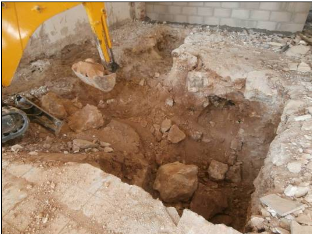
Fotografia 8: Procés d'excavació de la cala de l'ascensor A, amb blocs de roca calcària.
