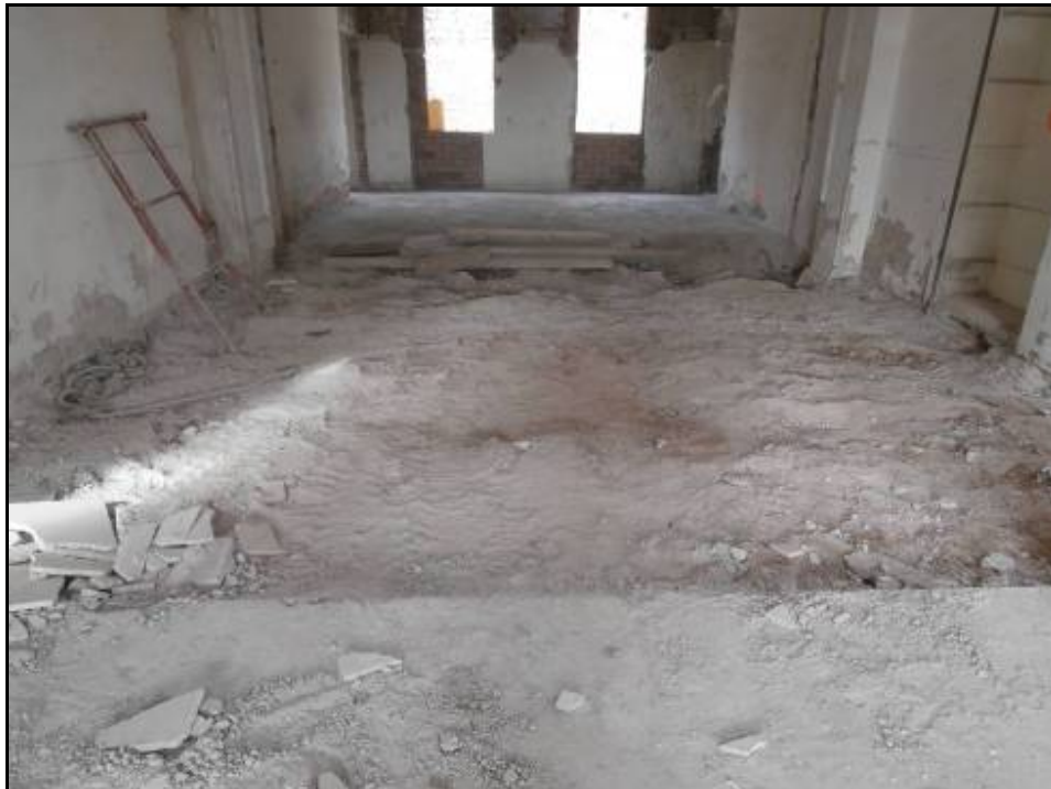
Fotografia 1: Espai dins de l'edifici A, on s'havia de fer el forat de l'ascensor A.
